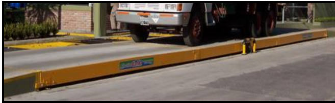
Plataforma de Hormigón
